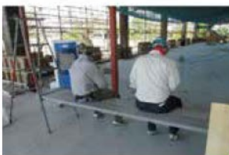
建築現場で使用
